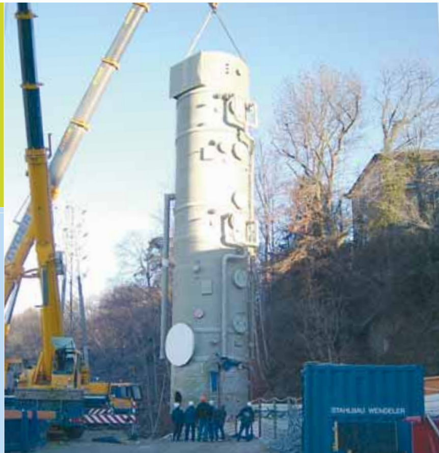
Montage der Rauchgaswaschtürme der Kehrichtverbrennungsanlage der Stadt Lausanne (TRIDEL).
