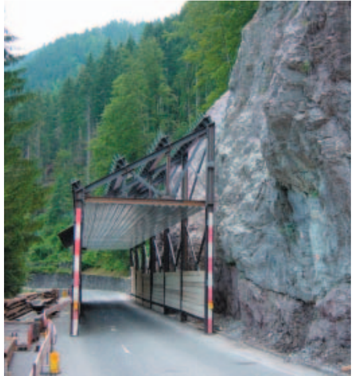
Provisorische Schutzgalerie für die Sicherheit und den Fluss des Strassenverkehrs.
