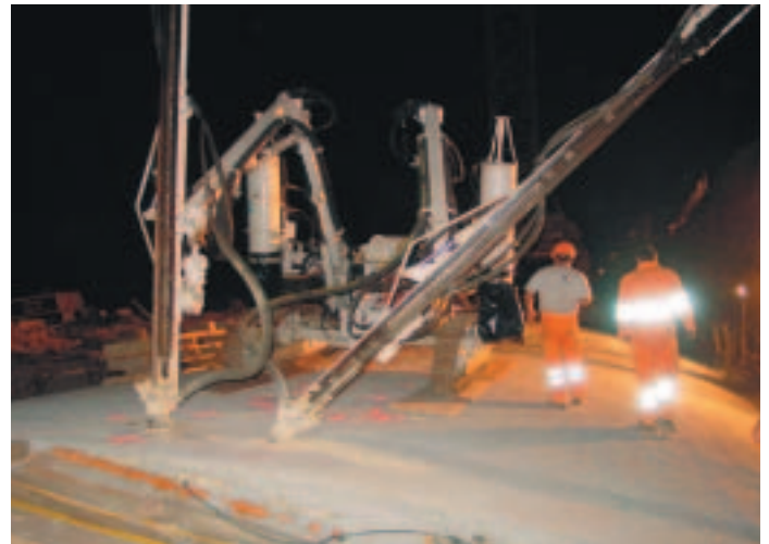
Die während der ganzen Bauarbeiten garantierte Betriebssicherheit stellt eine der schwierigsten Randbedingungen dar.
