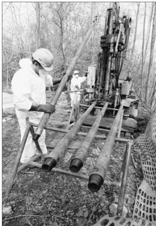
Extraites par la foreuse (à g.), les carottes révèlent le contenu de l'ancienne décharge. Le trou sert ensuite à prélever des échantillons d'eau souterraine
