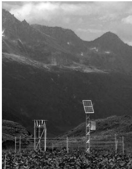
Abb. 1. Niederschlagsmessstelle im höher gelegenen Einzugsgebiet Ebenen (Witenwasserental) mit Präzisionswaage und Windfang (links), mit Logger, GSM-Verbindung und Solarstromversorgung rechts.
