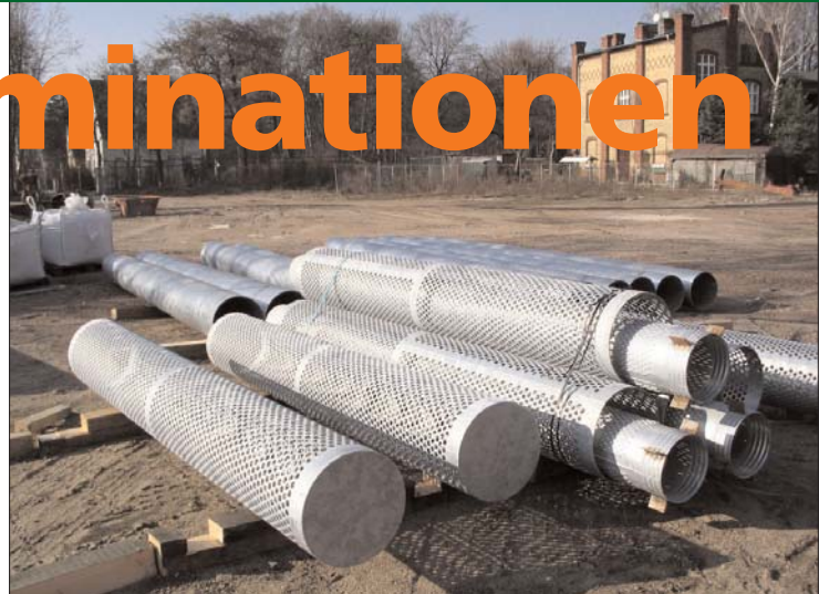
Abb. 1: Bodenzüstfilter DN 800 (Ausbaumaterial für unteren Filter des Grundwasserzirkulationsbrunnens).
