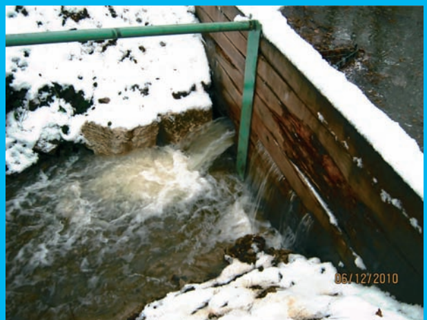
Début décembre 2010, suite aux importantes précipitations et dans une période de fonte des neiges, le barrage a déjà aidé à réguler les eaux.
